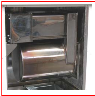
Chambre de combustion à retour de flamme et échangeur de chaleur à haut rendement en acier inoxydable
